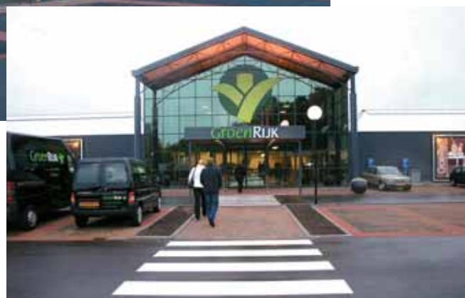
Il garden center Groenrijk De Carlton dopo la ristrutturazione.
